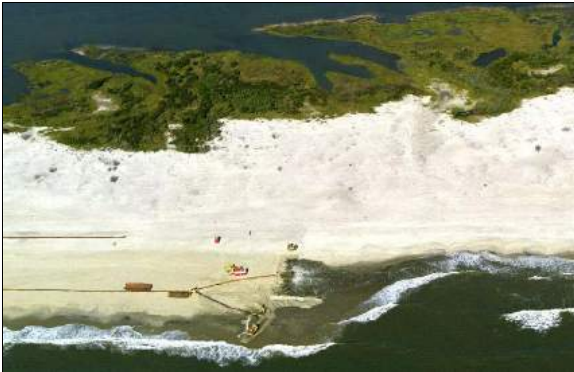
Figura 4-65 – Ejemplo de proceso constructivo de relleno de playas (tomado de https://www.nps.gov/articles/beach-nourishment.htm ).
