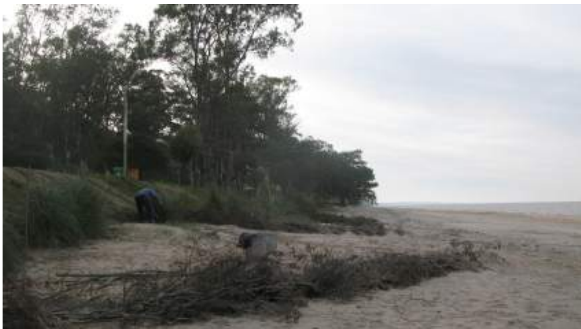
Figura 4-73. Cercas captoras en peine realizadas en Parador chico, Kiyú 2016
