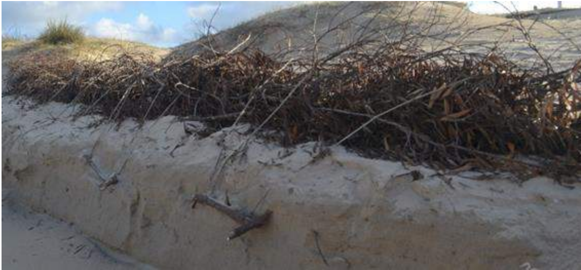
Figura 4-75. Corte de duna recuperada en experiencias anteriormente documentadas donde se aprecian anclajes y ataduras con hilo sisal.
