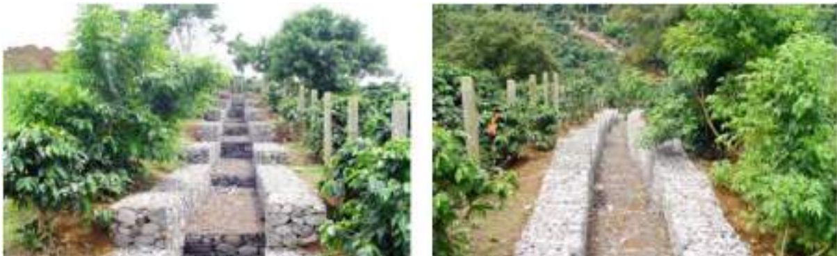
Figura 4-77. Ejemplo de gaviones colocados para disipar energía.
