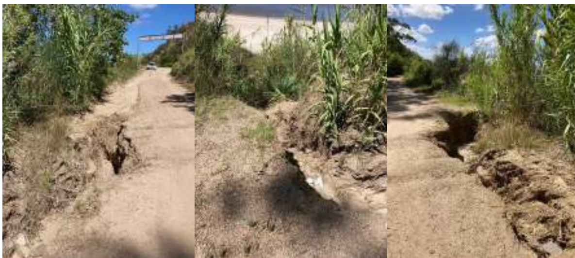
Figura 4-52. Fotos de cárcavas presentes en la calzada por causa de la escorrentía pluvial.
